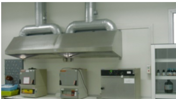
ภาพที่ 4.6 แสดง ตู้ชีวนิรภัยและ Hood ดูดควัน ไอสารเคมี
