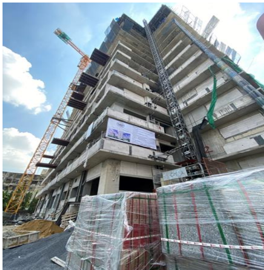
รูปที่ ๔ แสดงแนวส่วนสูงอาคารและการดึงแนวเปิดช่องพื้น เพื่อติดตั้ง BUS DUCT
