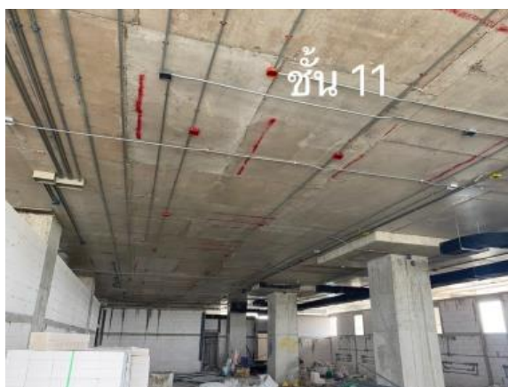
รูปที่ ๕ แสดงการเดินท่อ และร้อยสาย
